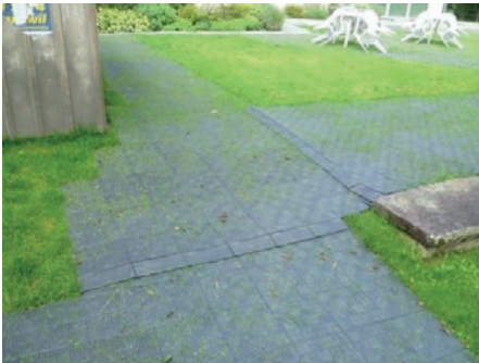
Bild 1: Verlegung ohne Geovlies, Rasen wird geschont und wächst sogar durch
