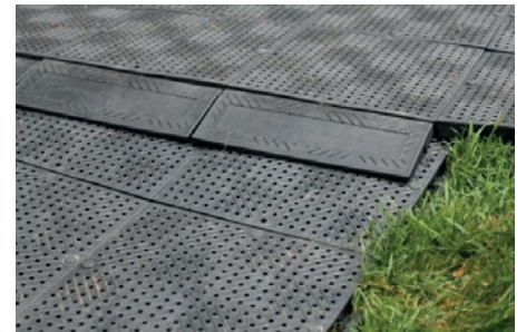
Bild 5: Dehnungsfuge überlappend
