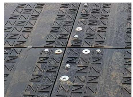
Die überlappende Verschraubung garantiert einen extrem stabilen Verbund der Fahrplatten für Arbeitsflächen und mobile Baustraßen. Schnelle Verbindung mittels M16-Schrauben an bis zu 7 Verbindungsstellen.
